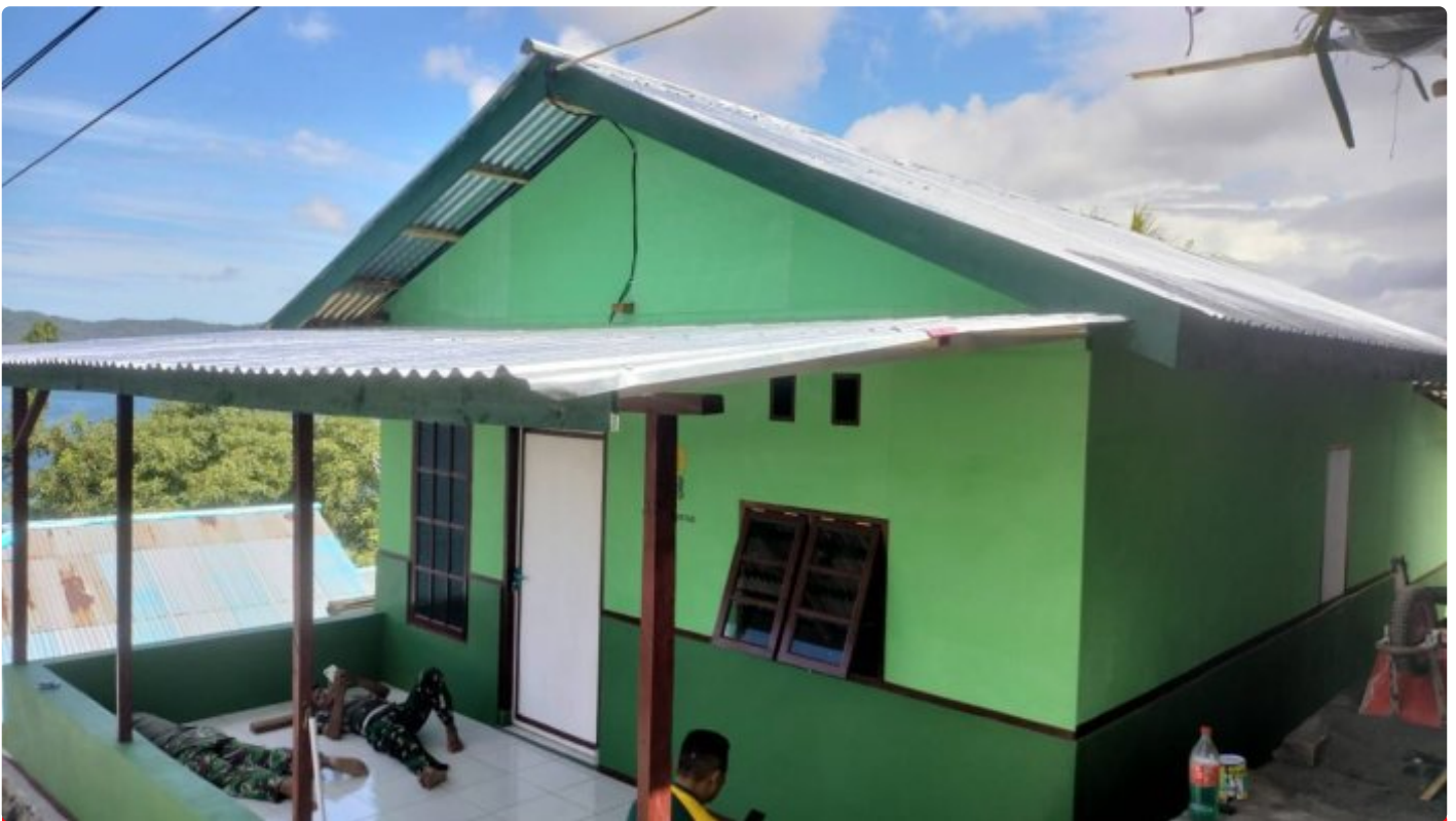
Renovasi RTLH TMMD Ke-116 Kodim 1310 Bitung
